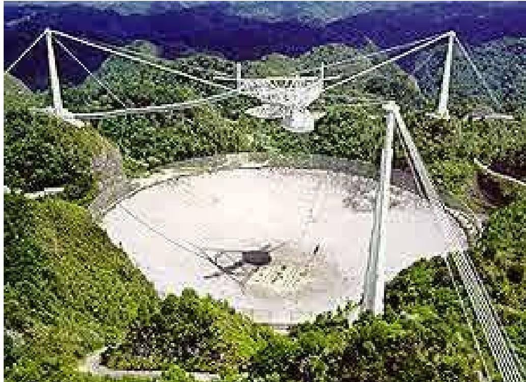
Antenne parabolique de 305 m de diamètre
